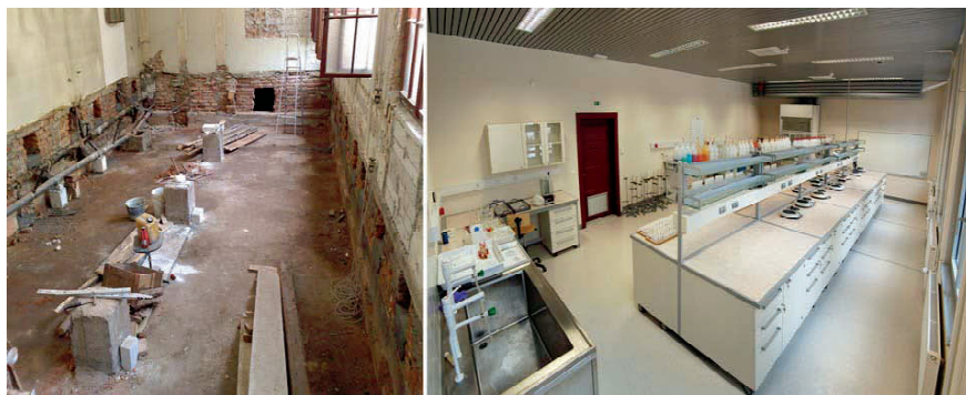
Na levi: gradbena dela - prostori v postopku prenove; na desni: zaključena dela - prenovljeni laboratoriji.
