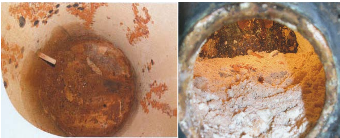
Slika 6: Sliki prikazujeta notranjost različnih toplovodnih zbiralnikov (19).
